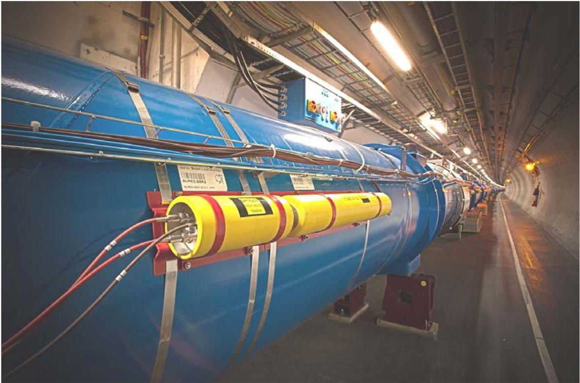
Foto 5.- Aspecto de uno de los túneles con el beam y acelerador montados para el LHC (Cortesía CERN)
