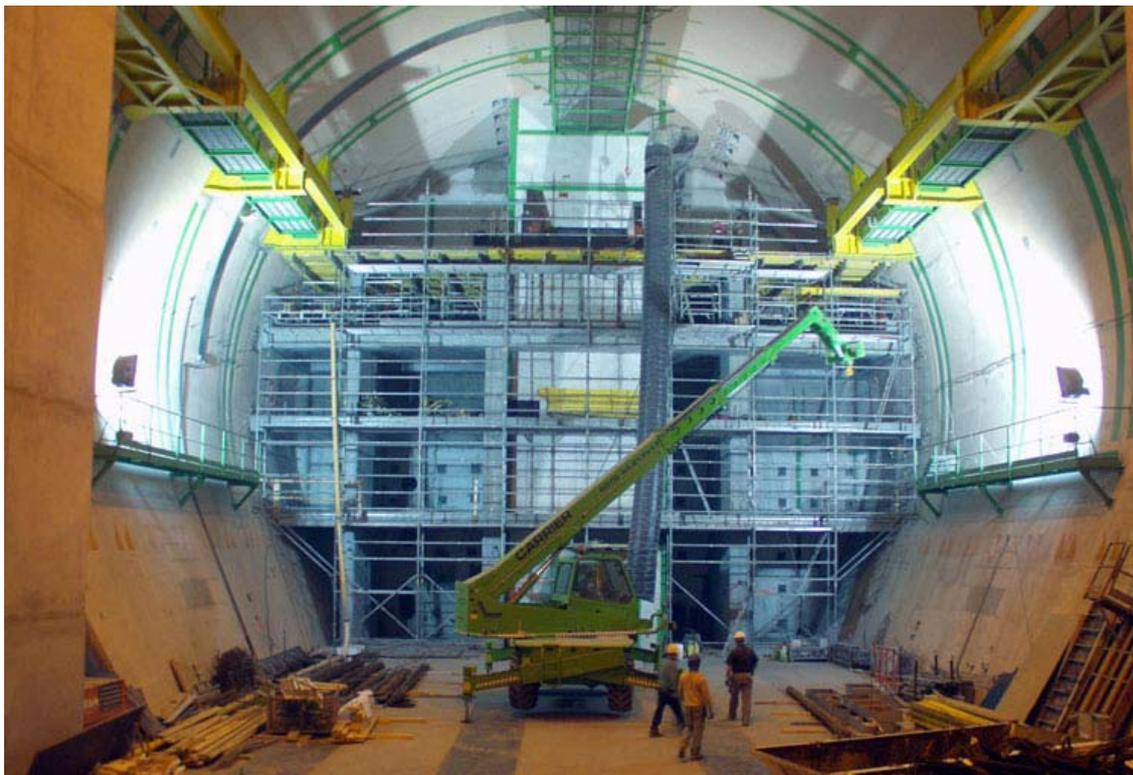
Foto 20.- Estructura de refuerzo de la pared vertical de la caverna UX85 (Cortesía CERN)
