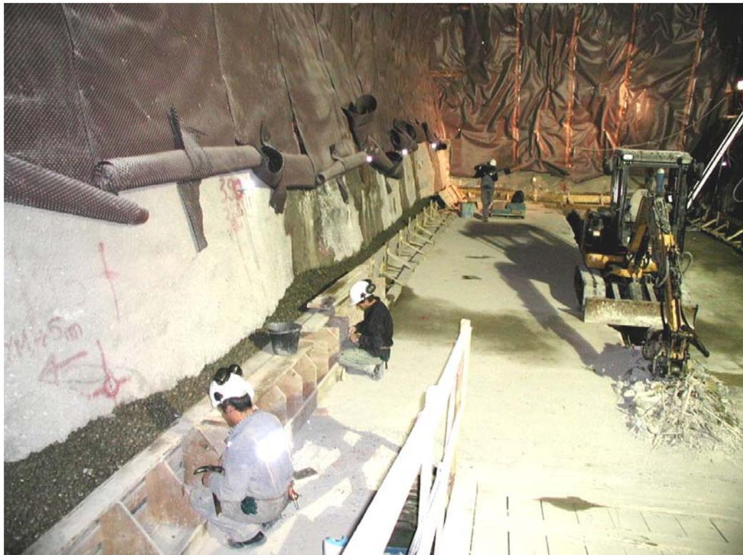
Foto 17.- Cámara UD68. Refuerzo del dren en el pie de hastiales. Véanse las humedades en segundo plano bajo la lámina (cortesía de Intecsa-Inarsa).
