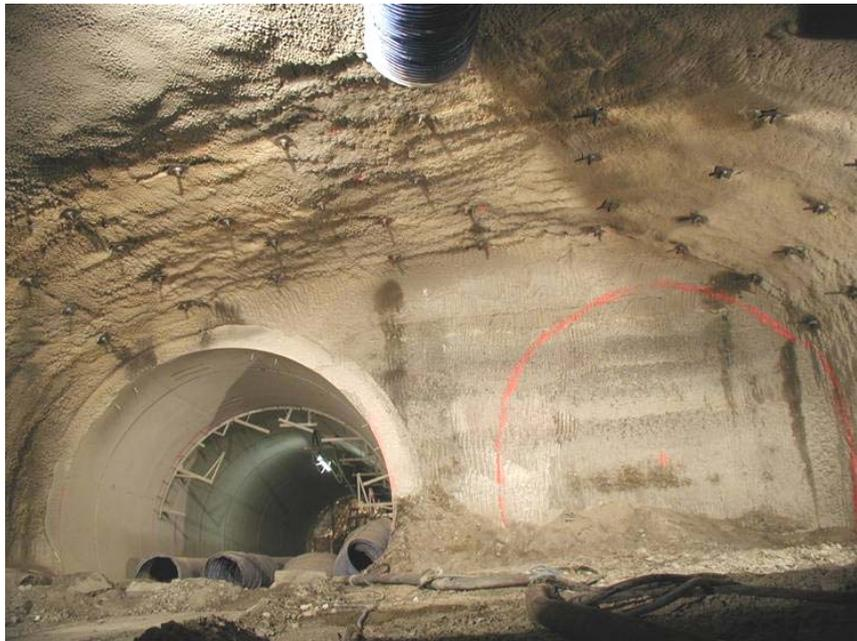
Foto 11.- Sostenimiento del ensanche para formar la cámara UX65 de acceso a los túneles TD62 y TD68 (cortesía de Intecsa-Inarsa).
