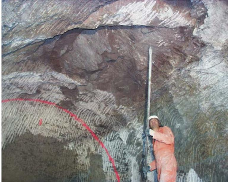
Foto 10.- Bloque desprendido en clave del T12 (cortesía de Intecsa-Inarsa).
