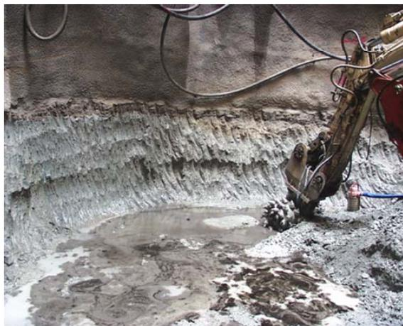
Foto 6.- Excavación con cabeza rozadora de la marga en el tercio inferior del pozo de acceso PMI2 (cortesía de Intecsa-Inarsa)
