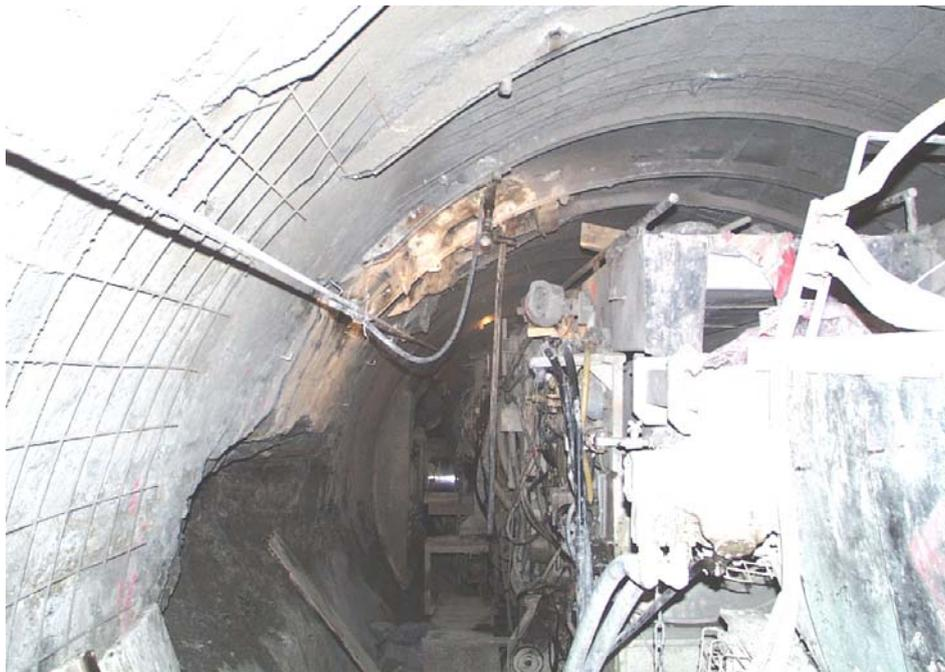
**Foto 9.- Codales dañando los hastiales del T18 (cortesía de Intecsa-Inarsa).**
