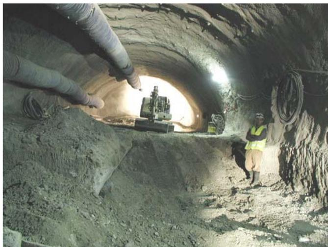
Foto 14.- Saneo de la solera en la UJ 68 (cortesía de Intecsa-Inarsa).
