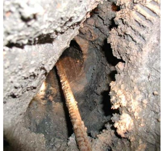
Fotos 15 y 16.- Cámara UD68. Al fondo se observa en la clave la zona con daños. A la derecha foto del sondeo en clave (cortesía de Intecsa-Inarsa).
