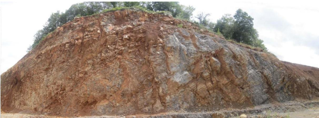
Foto 2. Calizas rojizas con karstificación en la primera mitad del desmonte D-8
