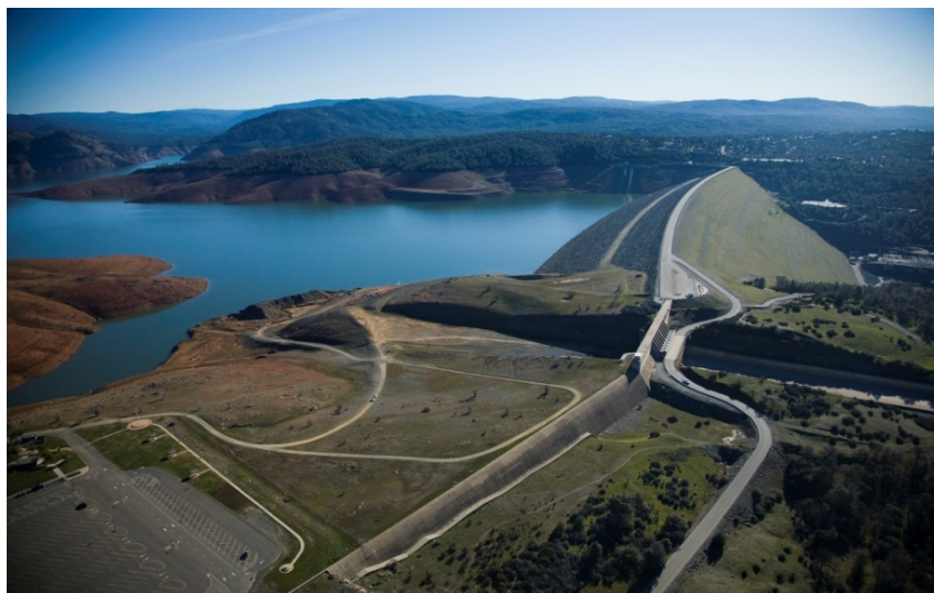
Imagen 1: Vista aérea de la presa de Oroville. En la parte inferior de la imagen se aprecia el aliviadero de emergencia (en primer término) y el aliviadero principal.
