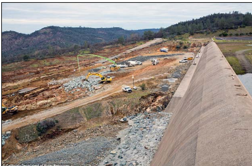
Imagen 6: Trabajos de reparación en el aliviadero de emergencia.
